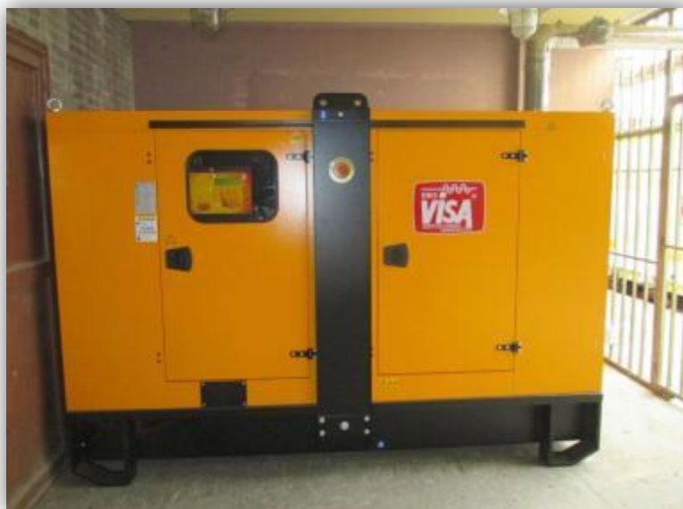
Motorgenerátor rady ONIS VISA s motorom IVECO v GKÚ Bratislava
